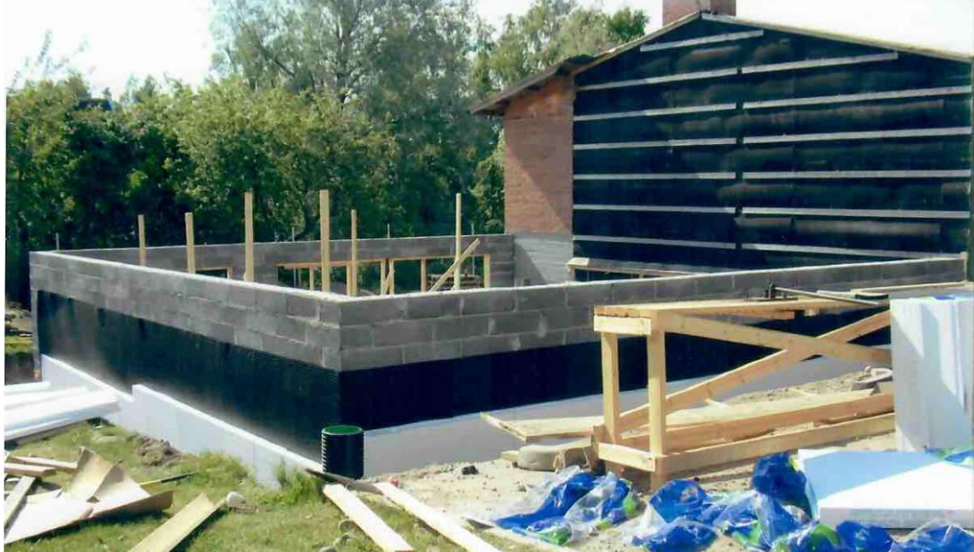
Kuva 10. Teollisuusrakennuksen laajennusosa (Lähde: Lahtinen, Jyrki. Kuvaaja. Oma arkisto. 2003.)
